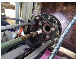
Réparation In Situ d'un piquage de réacteur
