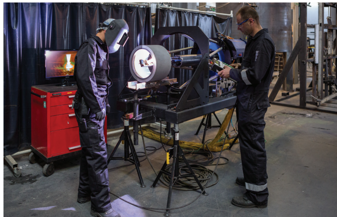
Rechargement d'un piquage avec Nozzlefuse 624
