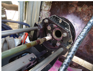
Reparación automatizada de tubuladuras en campo
