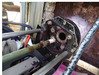
Automatisierte Vor-Ort-Reparatur von Stutzen
