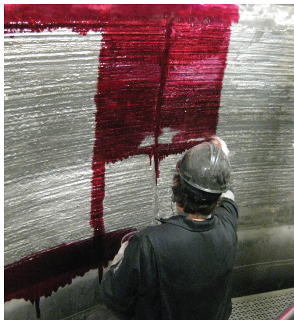
Ispezione PT del rivestimento di saldatura
