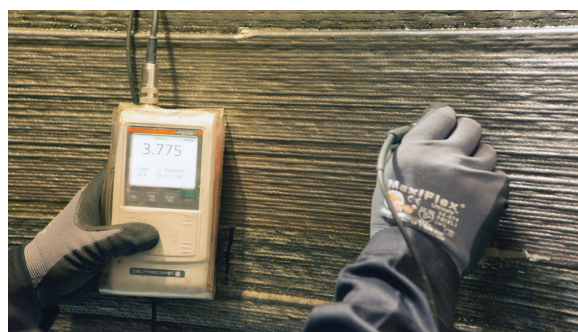
Letture UT dello spessore del rivestimento
