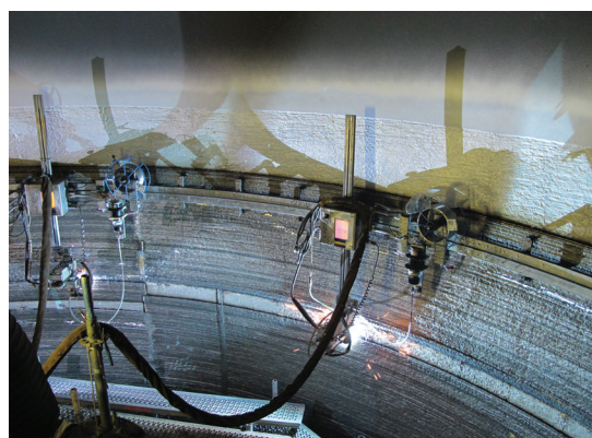
Rechargement par soudage automatisé via le processus Unifuse
