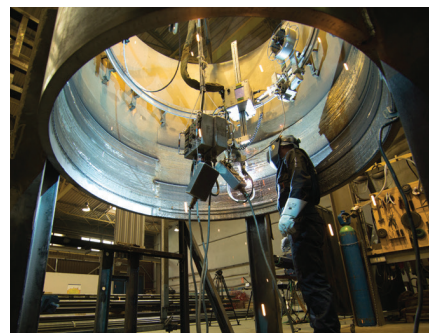
Maquette d'un rechargement par soudage automatisé
