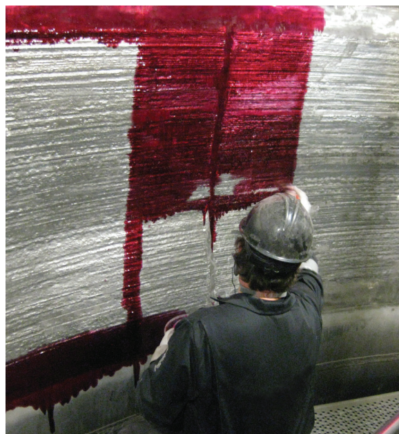
Ressuage (PT) du rechargement
