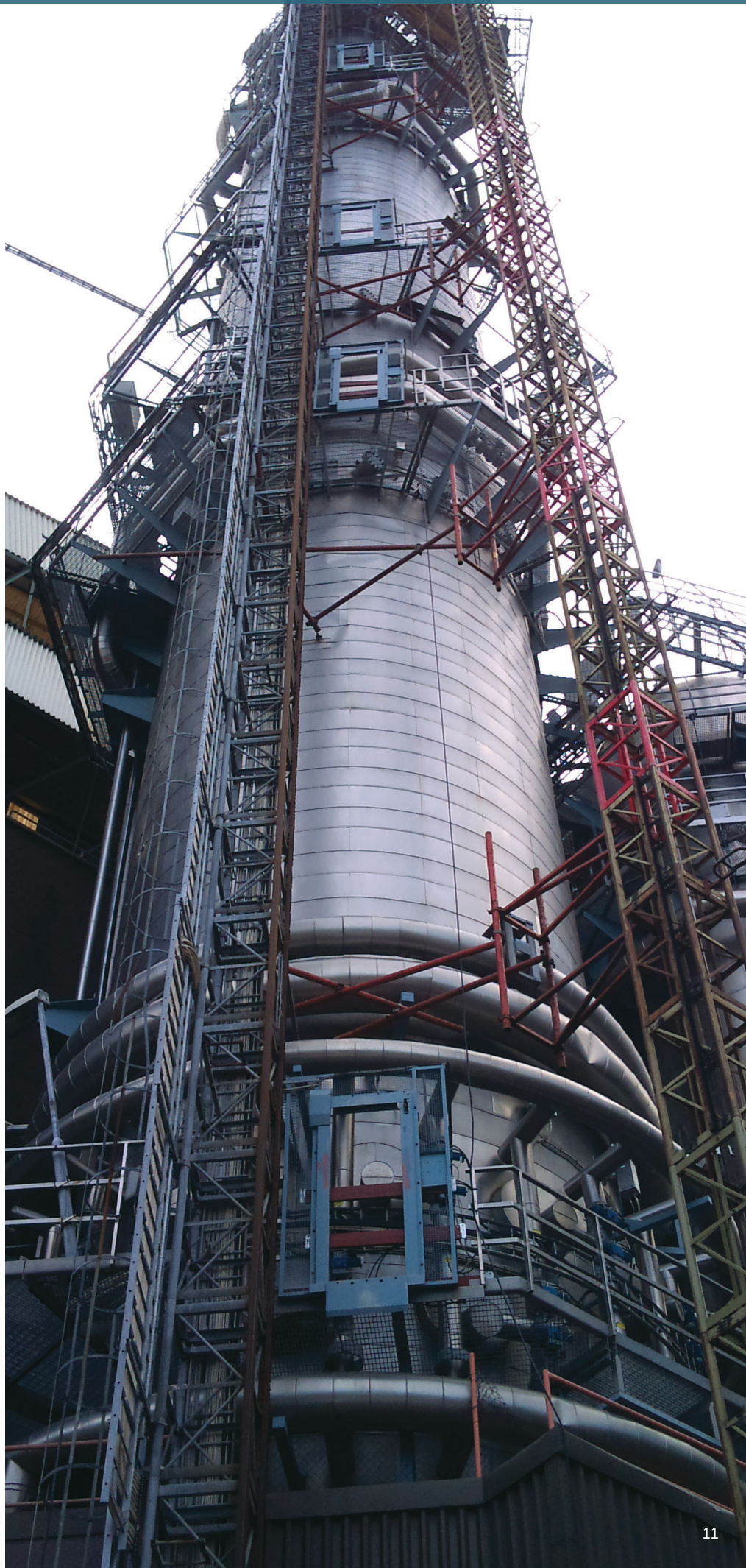
Reparación de WSI en un digestor
