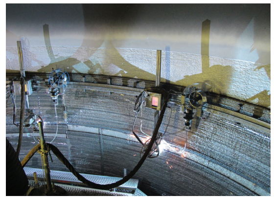
Recargue con soldadura automatizada utilizando el proceso Unifuse
