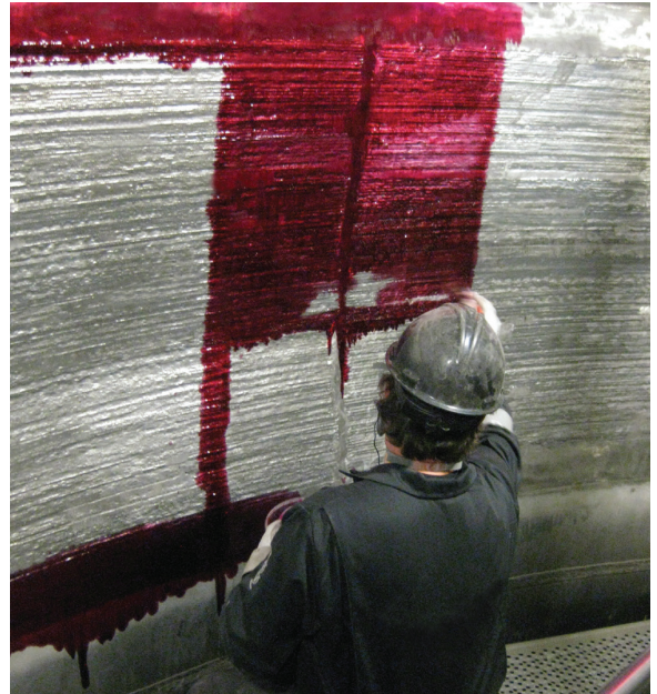
PT-Inspektion der Auftragsschweißung
