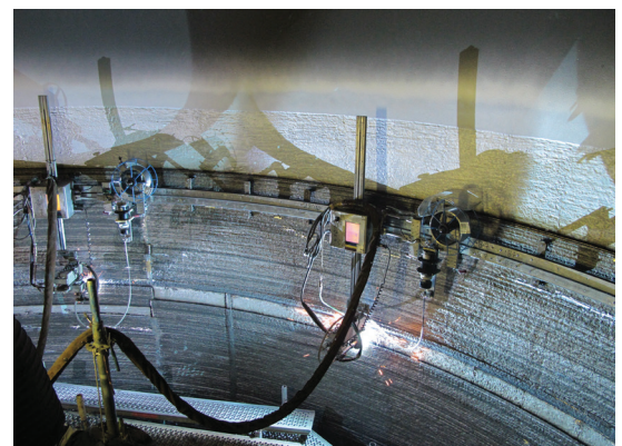
Automatisierte Auftragschweißtechnologie nach dem Unifuse-Verfahren
