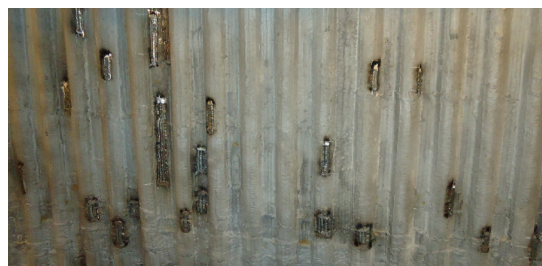
Riparazioni immediate su un vecchio riporto di saldatura 625
