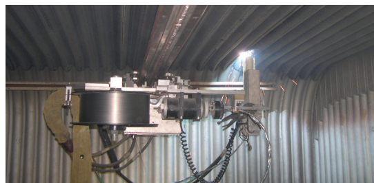
Se il danno è esteso, si deve applicare un riporto di saldatura Unifuse automatico per ripristinare lo spessore richiesto del riporto di saldatura.
