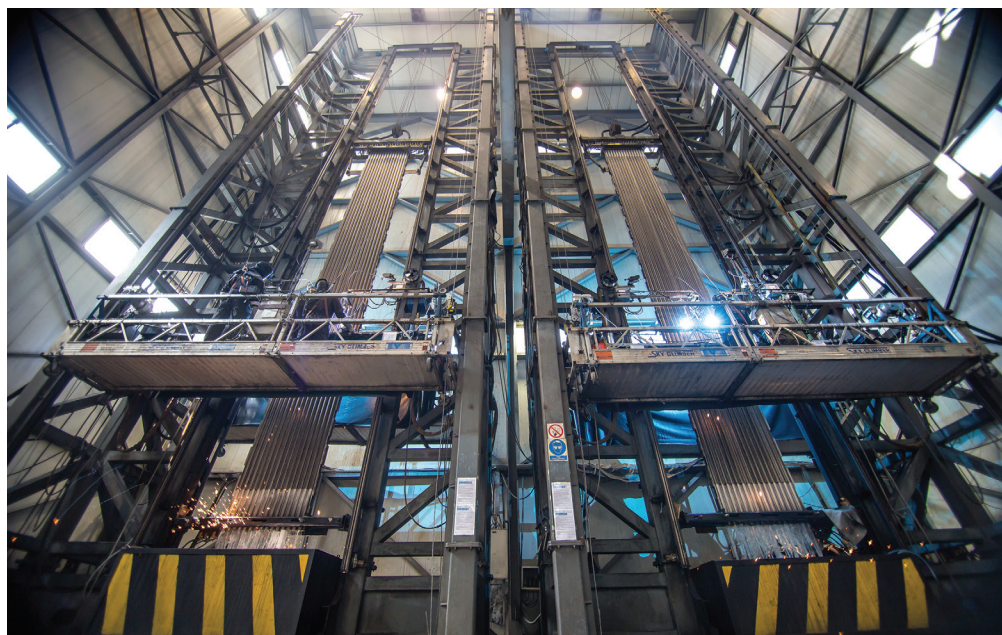
Prolongement de la durée de vie des panneaux de chaudière
