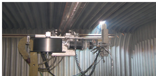
Si los daños son extensos, habrá que realizar un recargue con soldadura Unifuse automático para recuperar el espesor necesario de la protección anticorrosiva
