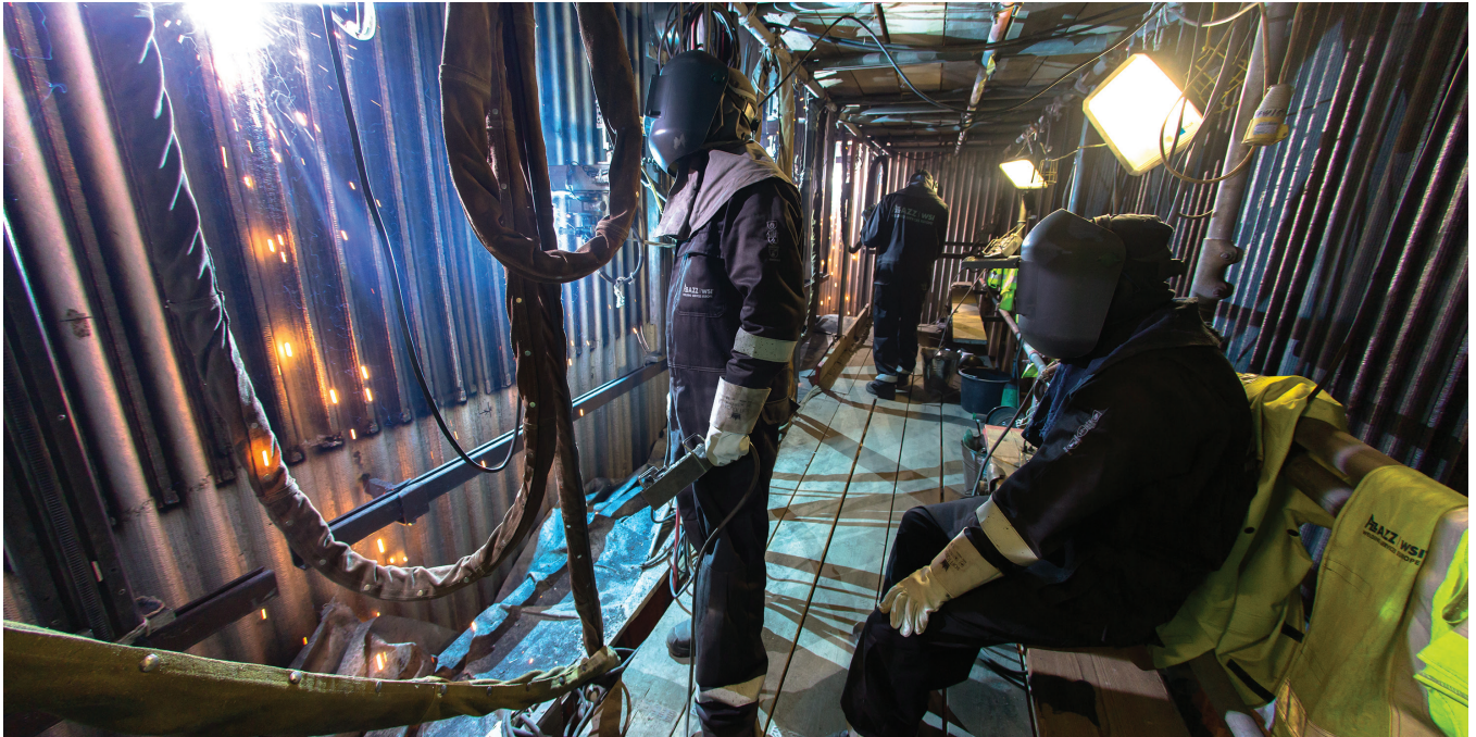
Rohrwandreparatur in einer Müllverbrennungsanlage
