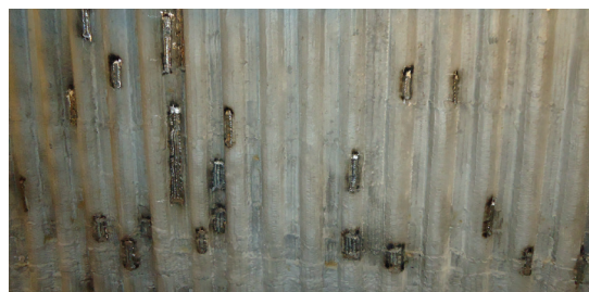
Punktuelle Ausbesserungen an einer alten 625 Auftragsschweißschicht
