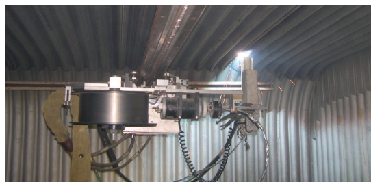
Wenn der Schaden großflächig ist, sollte die Unifuse Auftragsschweißung automatisch durchgeführt werden, um die erforderliche Dicke der Auftragsschweißschicht wieder herzustellen.
