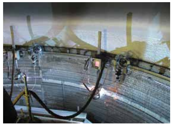
Recubrimiento con soldadura automatizada utilizando el proceso Unifuse
