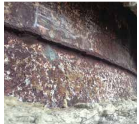
Grieta circunferencial en faldón
