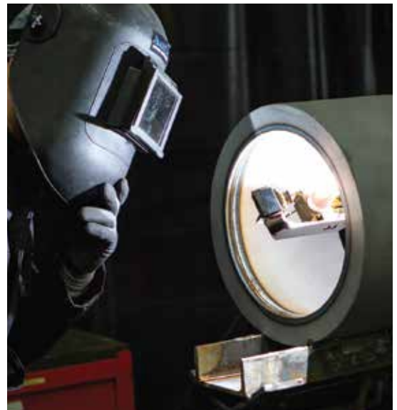
WSI ofrece una solución de reparación totalmente automatizada para un diámetro de interior desde 2" hasta boquillas y bocas de hombre de 24"
