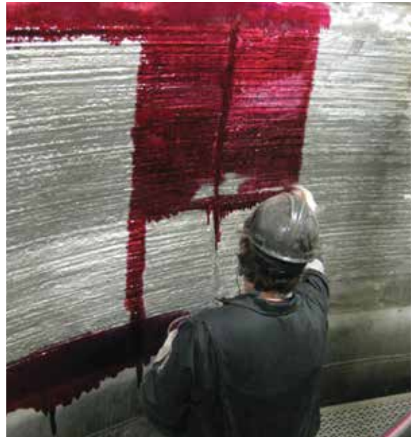
Inspección PT del recubrimiento con soldadura
