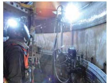
El personal está equipado con los materiales de seguridad necesarios
