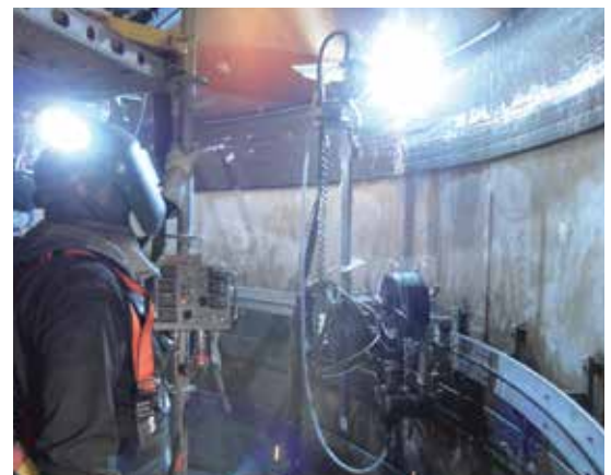
Personnel équipé de tout le matériel de sécurité nécessaire
