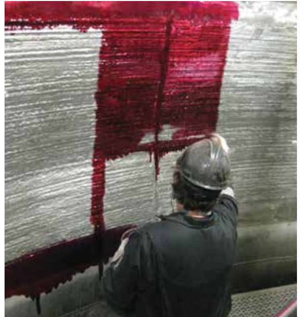
PT-Inspektion der Auftragschweißung
