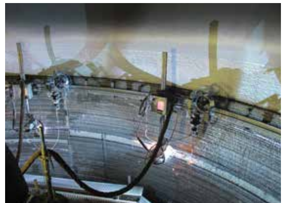
Automatisierte Auftragschweißtechnologie nach dem Unifuse-Verfahren
