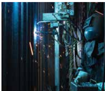
Reparación en una caldera de incineración
