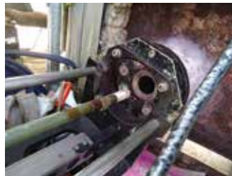
Reparación automatizada de boquillas en campo
