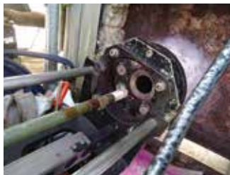
Riparazione automatizzata di un ugello direttamente sul campo
