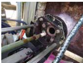
Réparation In Situ d'un piquage de réacteur
