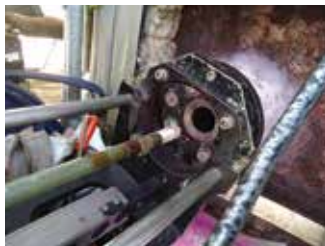
Reparo automatizado de bocal em campo
