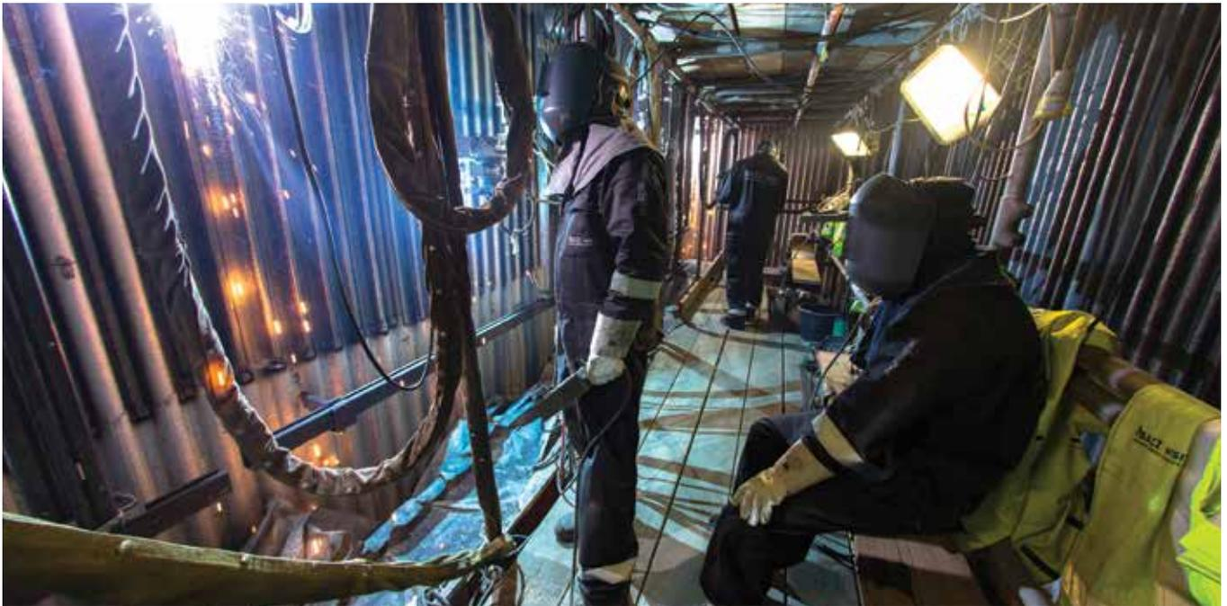
Reparación de pared de agua en una instalación de producción de energía a partir de residuos
