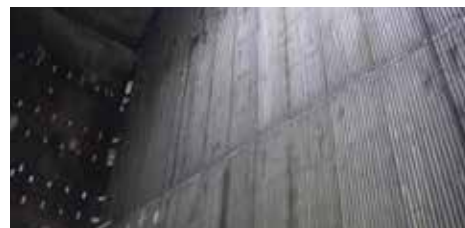
Reparaturen von WSI mit Unifuse 622 verlängern die Lebensdauer des kohlebefeuerter Kessels
