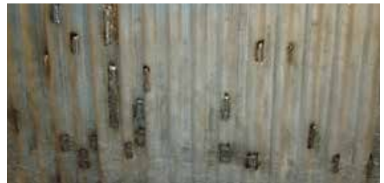
Punktuelle Ausbesserungen an einer alten 625 Auftragsschweißschicht
