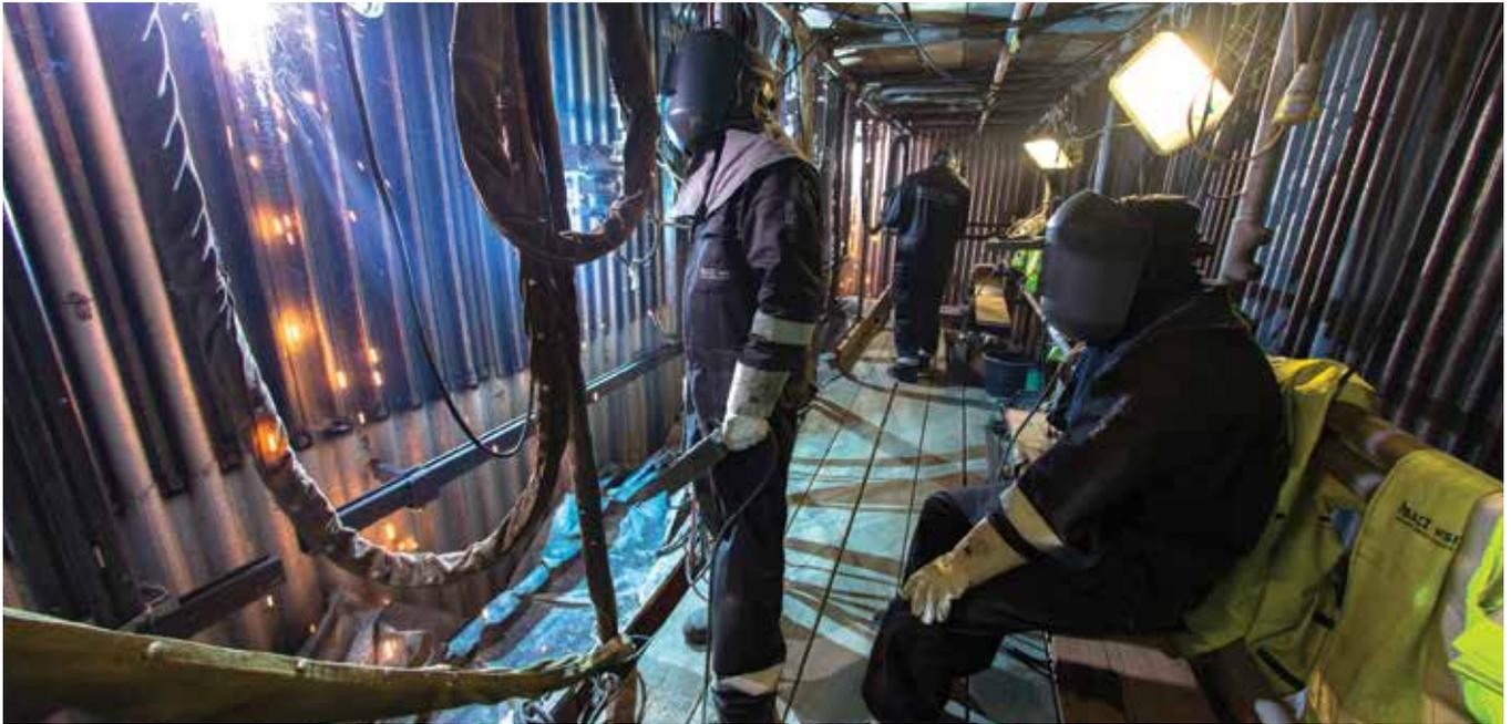
Reparo de uma parede tubo-tubo em uma Unidade de Energia de Resíduos
